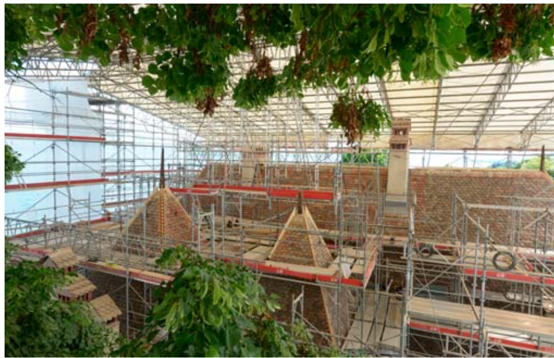
Sous le toit de toiles, la charpente a été restaurée et une partie des tuiles conservée.
